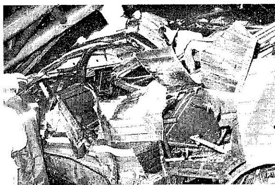
圖 16 a 臺北市北門高架道路工程的鋼架被風吹落壓沒車輛
