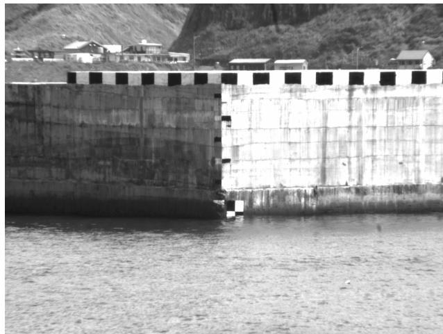
圖90 外堤水尺完工圖
