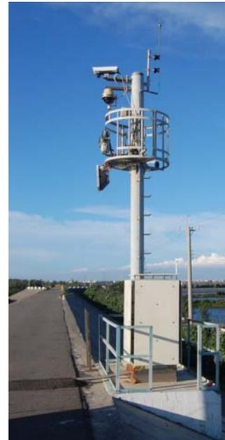
圖2-4 水利署設置在岸邊的海岸影像監測系統外觀
