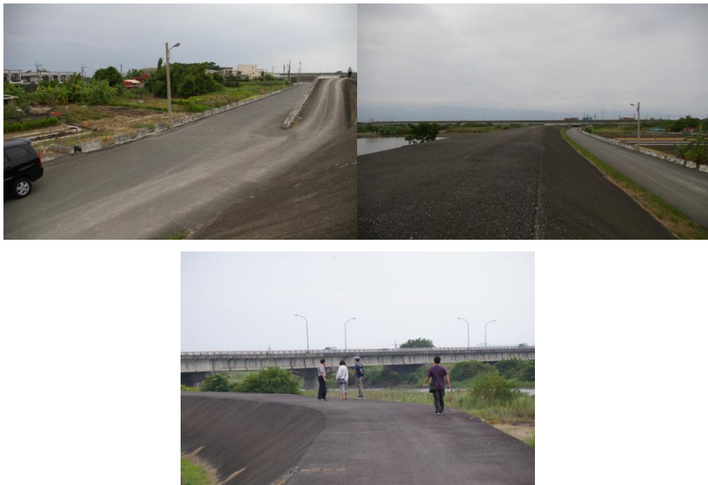
圖 13: 壯圍鄉東港村水閘門旁河堤-(a)觀測點入口、(b)觀測點往上游看、(c)雷達預定架設位置。
