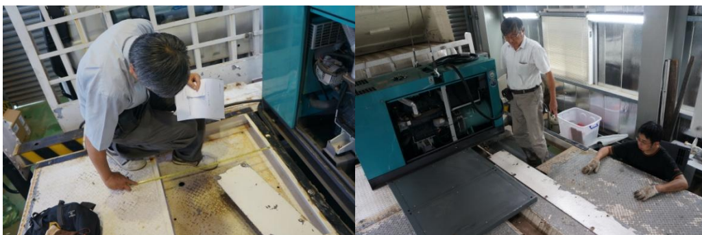
平台尺寸丈量及發電機重新定位
