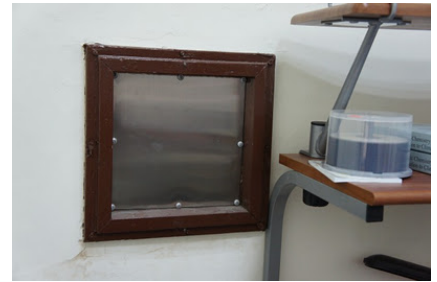
圖 49（左）、50（中）、51（右）。當年光象室作為引光用的方形窗孔。
