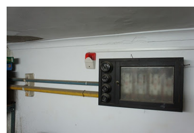
圖 3. 地下室 A115 室留有帝國大學時代電氣管線的原始塗裝樣貌。
