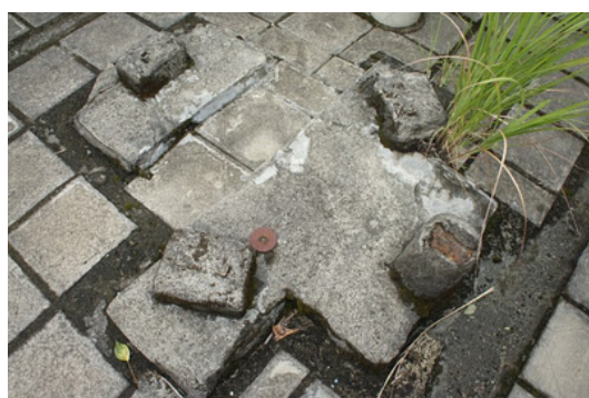
圖 62. 風力塔曾裝有儀器的基座痕跡。
