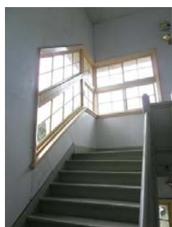
圖 12. 舊有樓梯窗戶為平行四邊形
