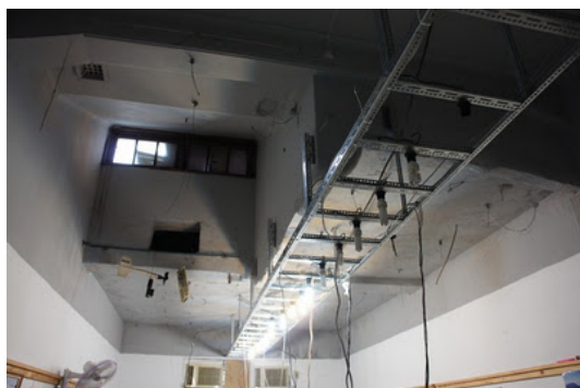
圖 17. 一進 A103 測計研究室是當年機械室與恆溫濕度調節室的空間，頂上有特別的通風窗設計。
