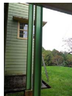
圖 15. 新建樓梯窗戶外觀
