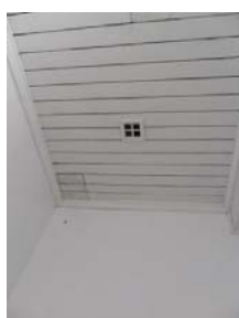
圖 9. 地震儀室天花板的透氣孔
