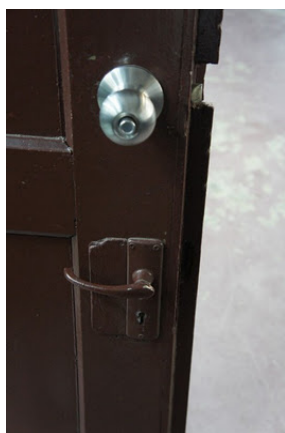
圖 42 (左)、43 (右).舊門把設置的地方相當低，與新門把有較大的高度差。右邊的人體實際使用可以清楚看出，新的門把較高，舊的很低。 圖 44. 物理系二號館的新舊門把高度差較小。
