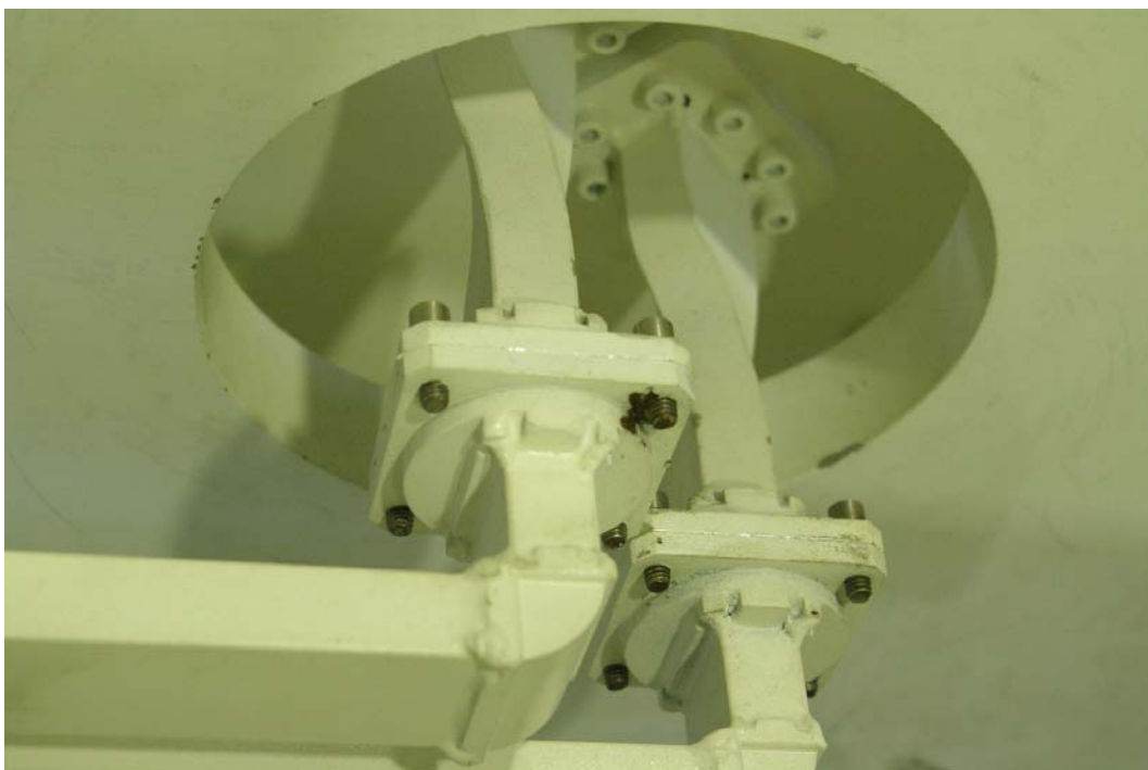
圖 23：修改後轉向方式，以整體導波管體漸轉方式達成轉向目的。
