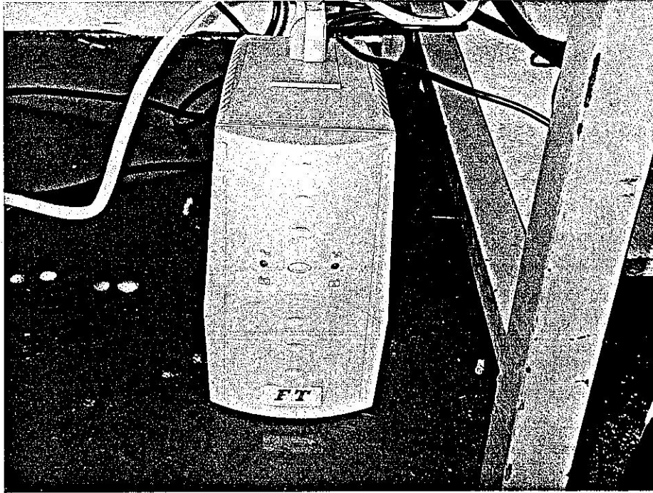
圖 3-15 位於機房內之不斷電系統
