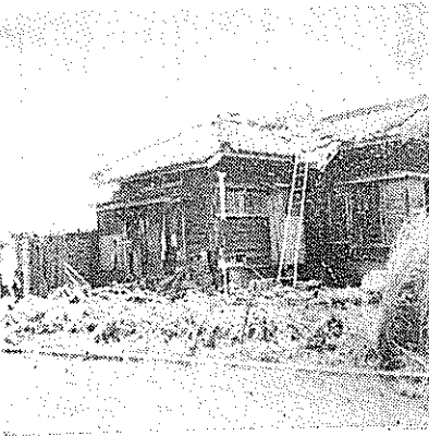
↑ 民權路警察局宿舍圍牆吹倒 屋頂損壞
